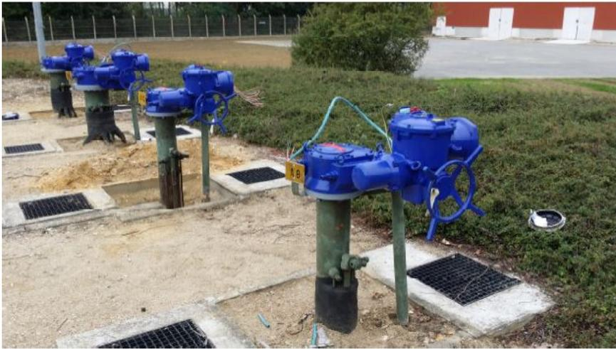
BERNARD CONTROLS a procédé à la mise en sécurité, au démontage des installations précédentes et au montage des nouvelles motorisations et réducteurs sur vannes quart de tour. BERNARD CONTROLS a également réalisé les pièces d'adaptation nécessaires, les essais, les réglages et la mise en service. L'intervention, délicate, nécessitait une expertise complète puisqu'il fallait prendre en compte l'ancienneté du matériel existant, l'inaccessibilité des vannes enterrées, et la présence de brides
