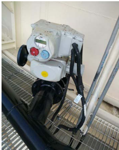
伯纳德控制设备用于大浦热电厂的 SQ 系列角行程执行器
