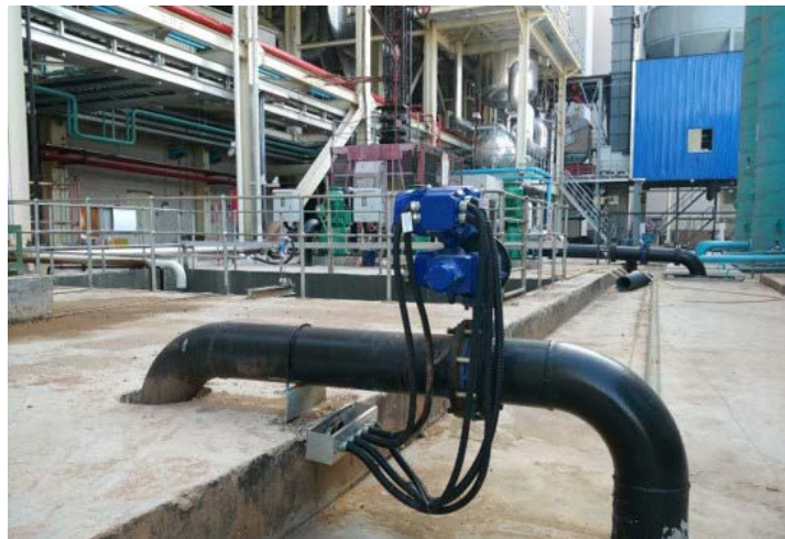
伯纳德控制设备用于大浦热电厂的 SQ 系列角行程执行器
